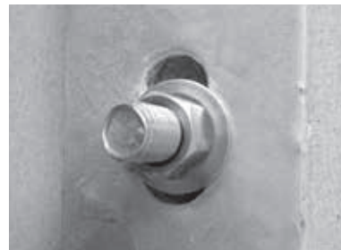
B: BPベース金物へ取付けたBPアンカー
