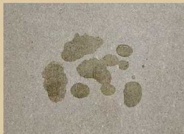
浸透性吸水軽減材塗布品：水染みあり
